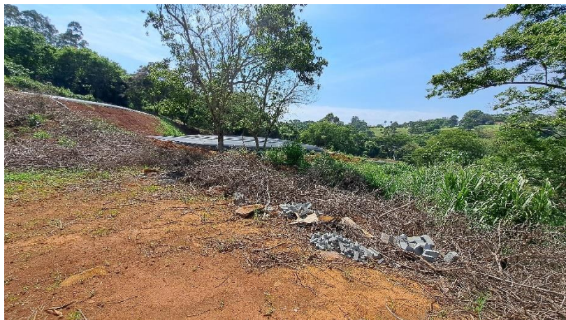
Foto 1 – Geobags na ETE Cidade.
