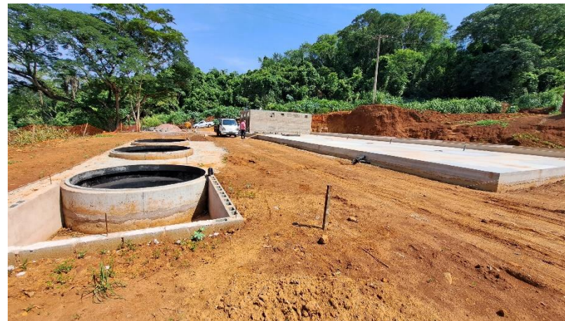
Foto 2 – Andamento das obras da ETE Modular Compacta.
