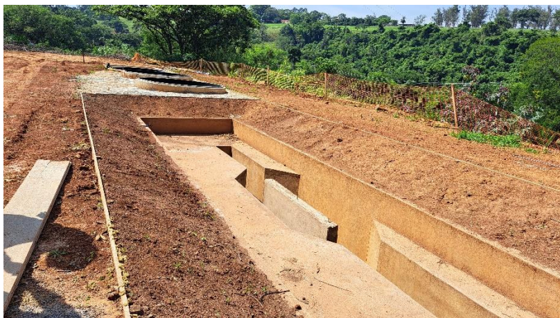
Foto 3 – Andamento das obras da ETE Modular Compacta.
