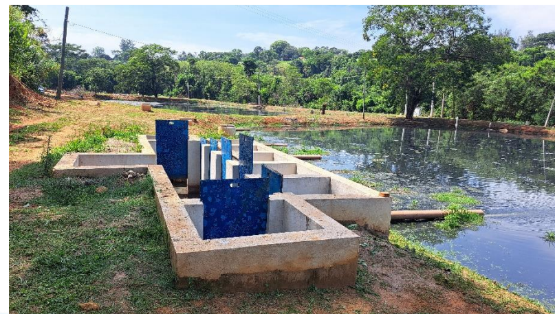
Foto 2 – Foto 1 – Melhorias na entrada de esgoto nas lagoas da ETE.
