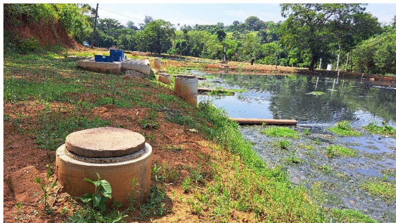
Foto 1 – Melhorias na entrada de esgoto nas lagoas da ETE.
