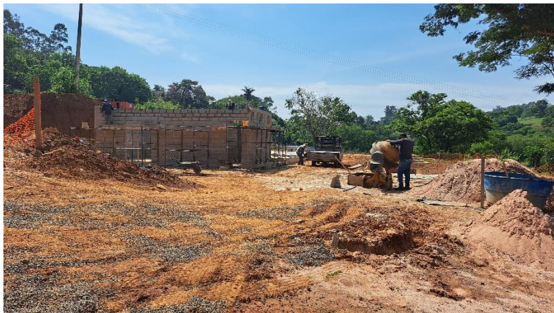
Foto 1 – Andamento das obras da ETE Modular Compacta.
