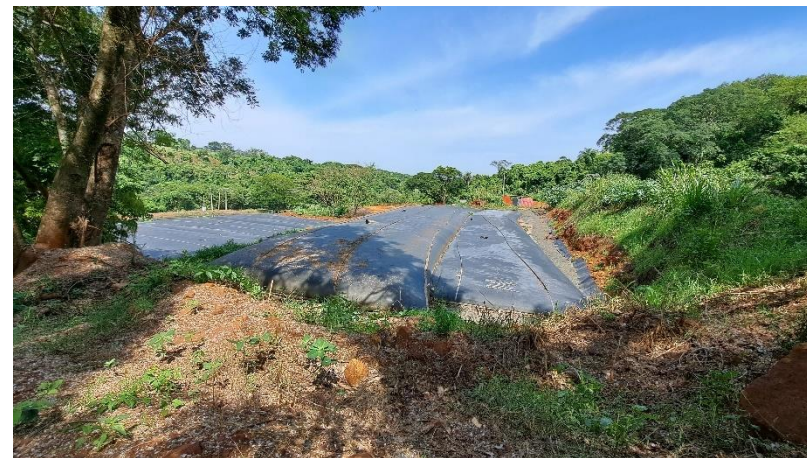
Foto 2 – Geobags na ETE
