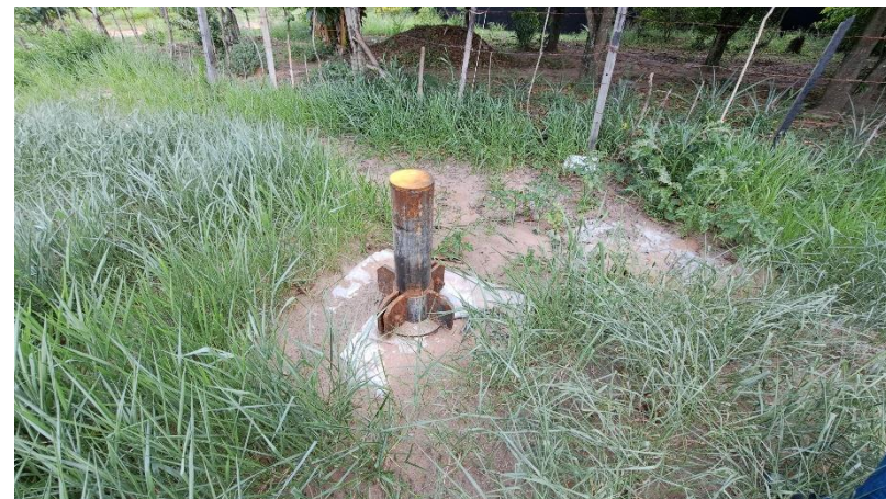
Foto 2 –Tubulação do poço já perfurado no bairro Lagoa Dourada (Broa), realizado pelo Governo do Estado de São Paulo.
