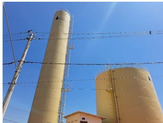
Novos Reservatórios do Jd. Santa Maria
