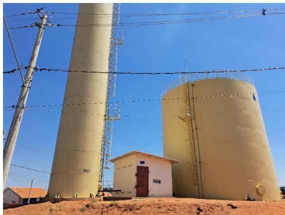
Novos Reservatórios do Jd. Santa Maria
