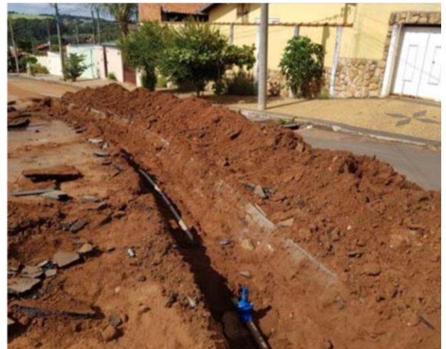
Implantação hidráulica do setor 06 – Fonte: Thesis Engenharia, 2022
