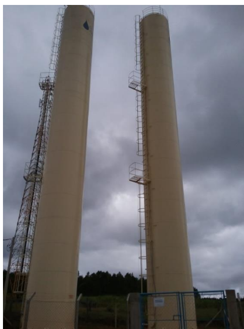
Figura 10 - Reservatórios do bairro Patrimônio concluídos
