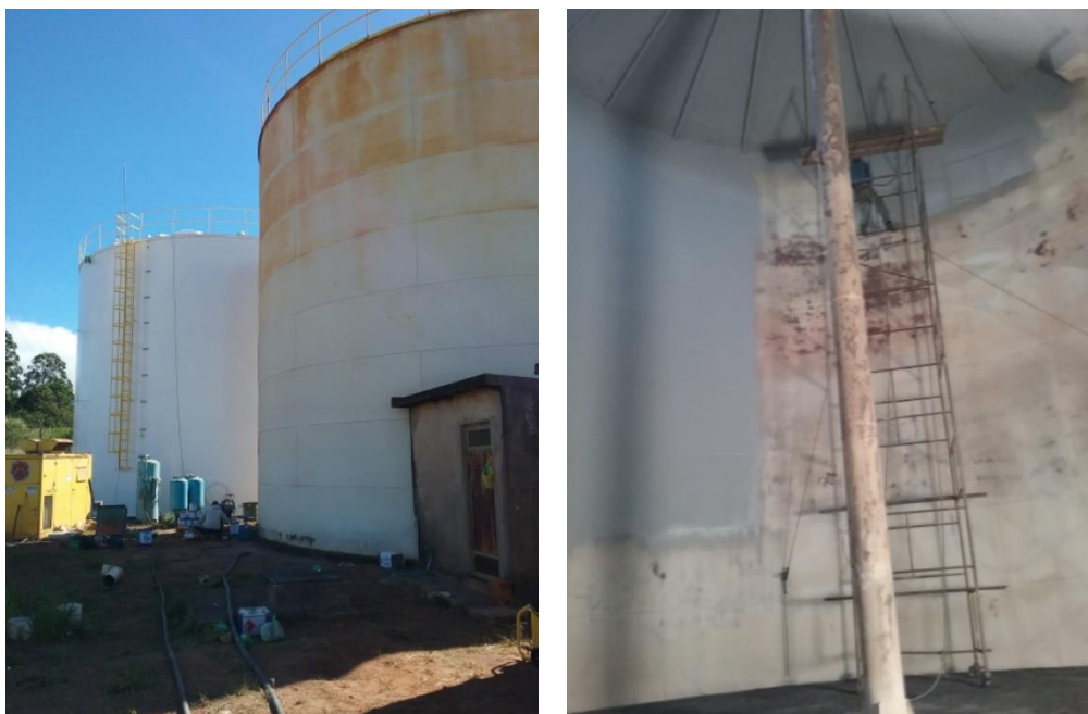
Figuras 8 e 9 - Reforma dos reservatórios da Polícia Rodoviária. A segunda foto mostra trabalho de revestimento interno do reservatório
