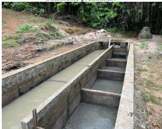
Figura 8. Vista dos canais em paralelo do tratamento preliminar.
