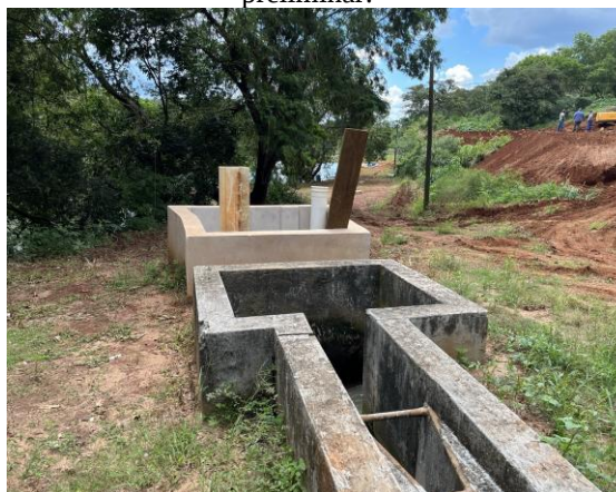
Figura 10. Vista da saída do tratamento preliminar.
